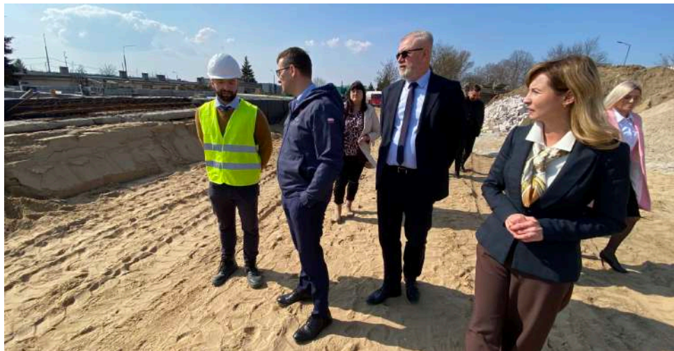
Wojewoda Michał Szybel i Magdalena Łośko, posłanka na Sejm RP wraz z burmistrzem Michałem Pęziakiem, na placu budowy Gminnej Bazy Bezpieczeństwa i Ratownictwa w Barcinie wraz z magazynami OC i OL
