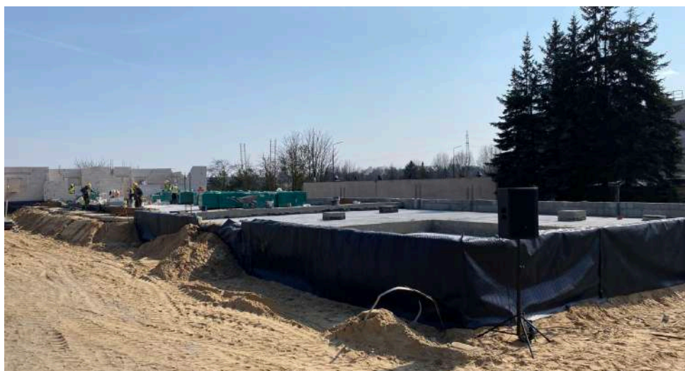
Stan budowy obiektu na dzień 23 marca br.
