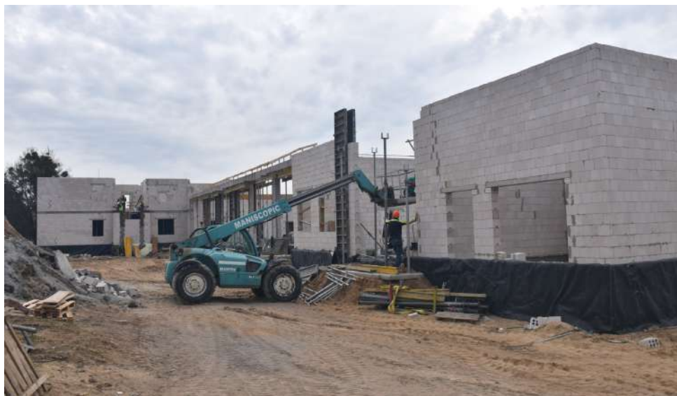
Stan budowy obiektu na dzień 16 kwietnia br.
