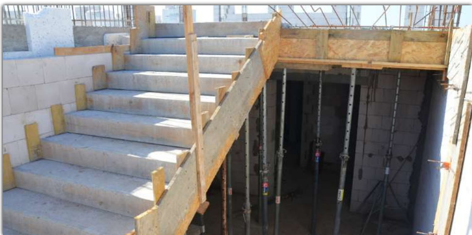
Wysoki parter oraz budowane piętro w obu budynkach, połączyły już schody
