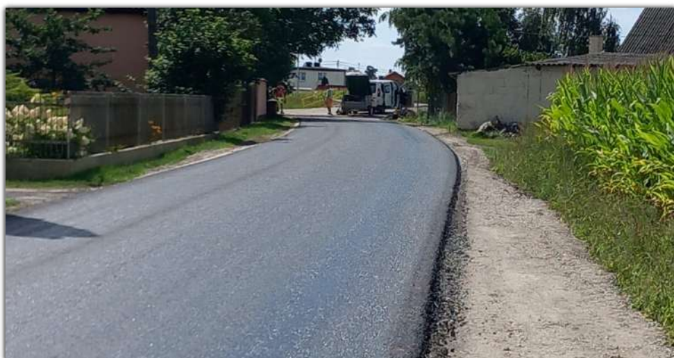
Łączna długość remontowanych odcinków wynosi 4,471 km
