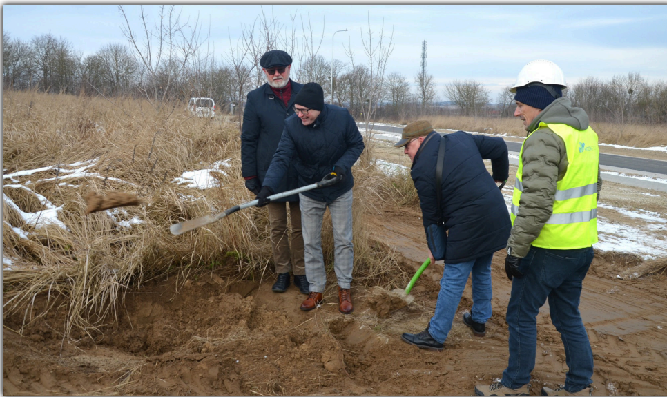
Symboliczna pierwsza łopata pod budowę dwóch bloków w Krotoszynie już wbita
